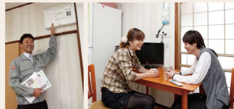
右／テレビアンテナの設置や電気コンセントの増加など、小さなことが快適生活の鍵に。 左／家中の電気管理をするブレーカーは、台所に設置。
